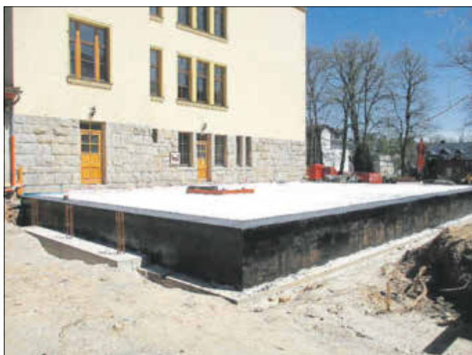
Errichtung Bodenplatte, Mai 2021
