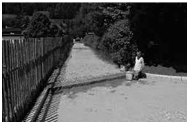
Ein Mitarbeiter der Fa. Pügner Landschaftsbau, Alexander Opelt, beim Herstellen und Verfugen der Pflasterrinnen.
