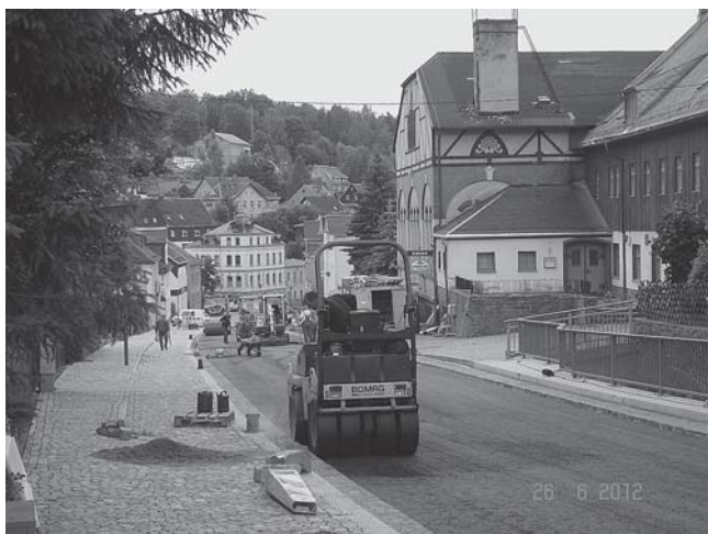
Einbau der Asphalt-Tragschicht im Bereich des ehemaligen Gasthofes „Krone“.
